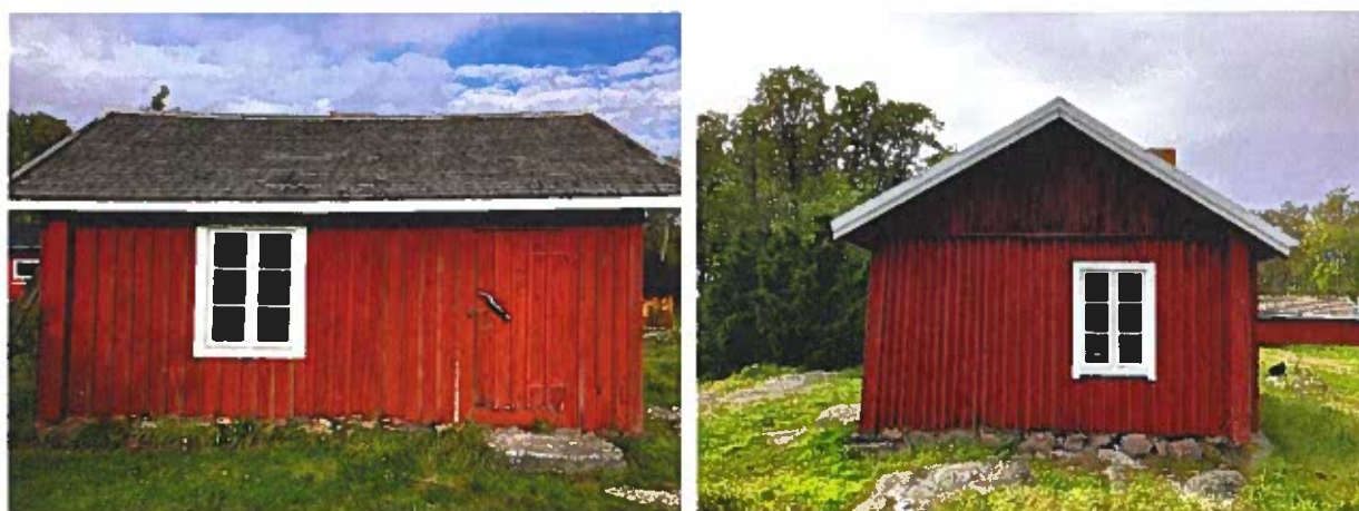
Figur 26 och 27. Bastubyggnaden sedd ifrån söder resp. öster.
