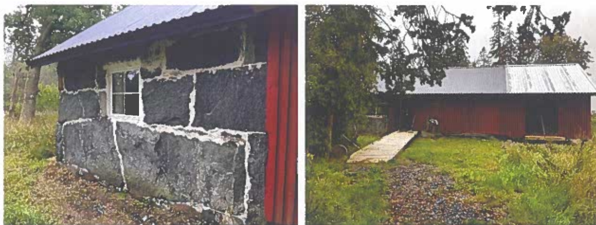
Figur 22 och 23. Ladugårdens norra sida.
