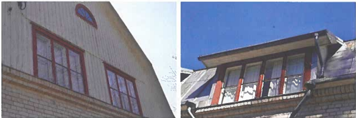
Figur 9 och 10. Övervåningens olika fönstertyper.
